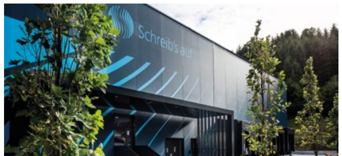
Logistikzentrum "Blulog", Weierhalden 37/1 in Schramberg-Tennenbronn
